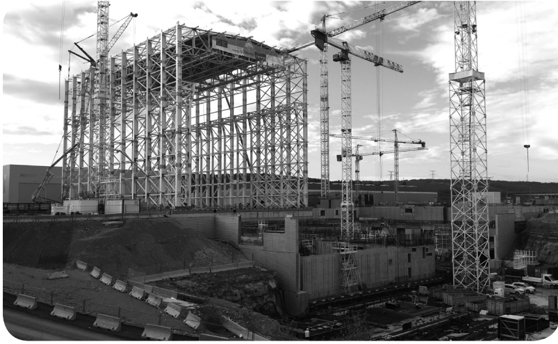
ITER 건설 현장과 액상프로방스의 청명한 하늘
